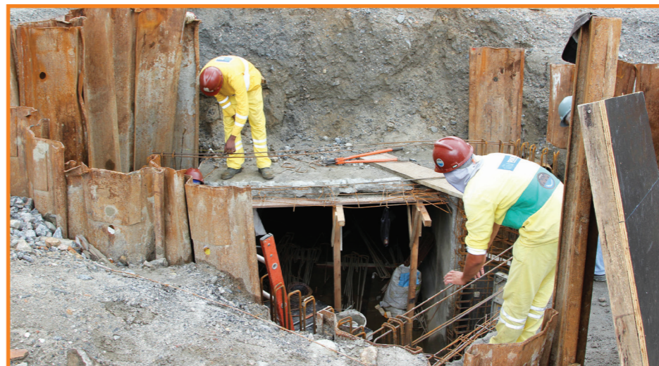
Ponto de deságue em execução na Rua Rivadávia Correia
