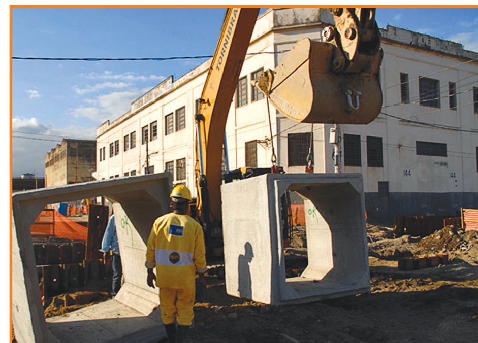
Obras de infraestrutura: novas redes terão capacidade de escoamento até 11 vezes maior do que a atual
