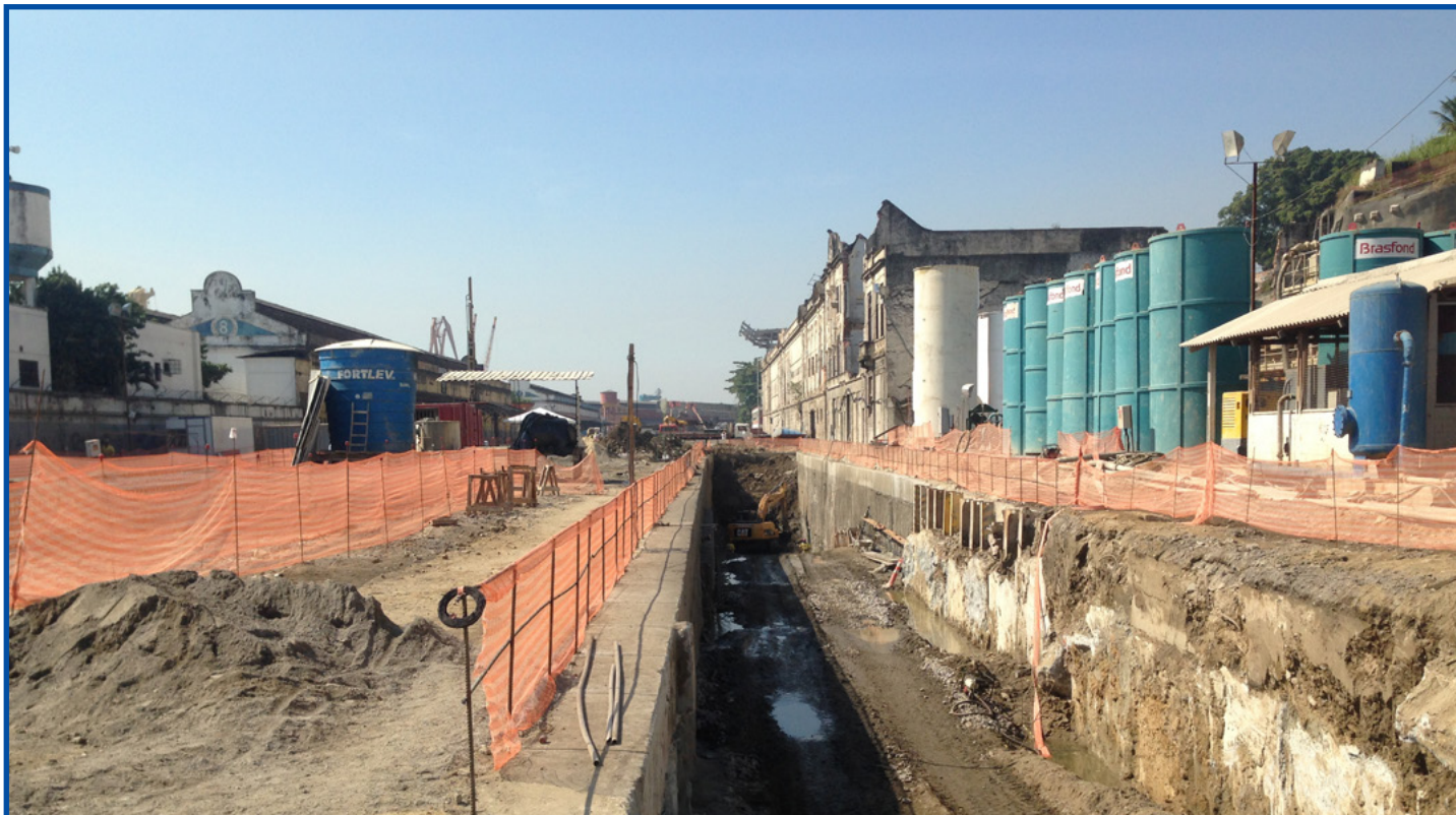
Obras da via que terá 6.847 metros estão avançadas
