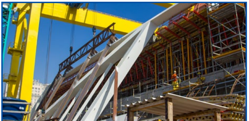
Instalada a primeira estrutura metálica da fachada lateral do Museu do Amanhã
