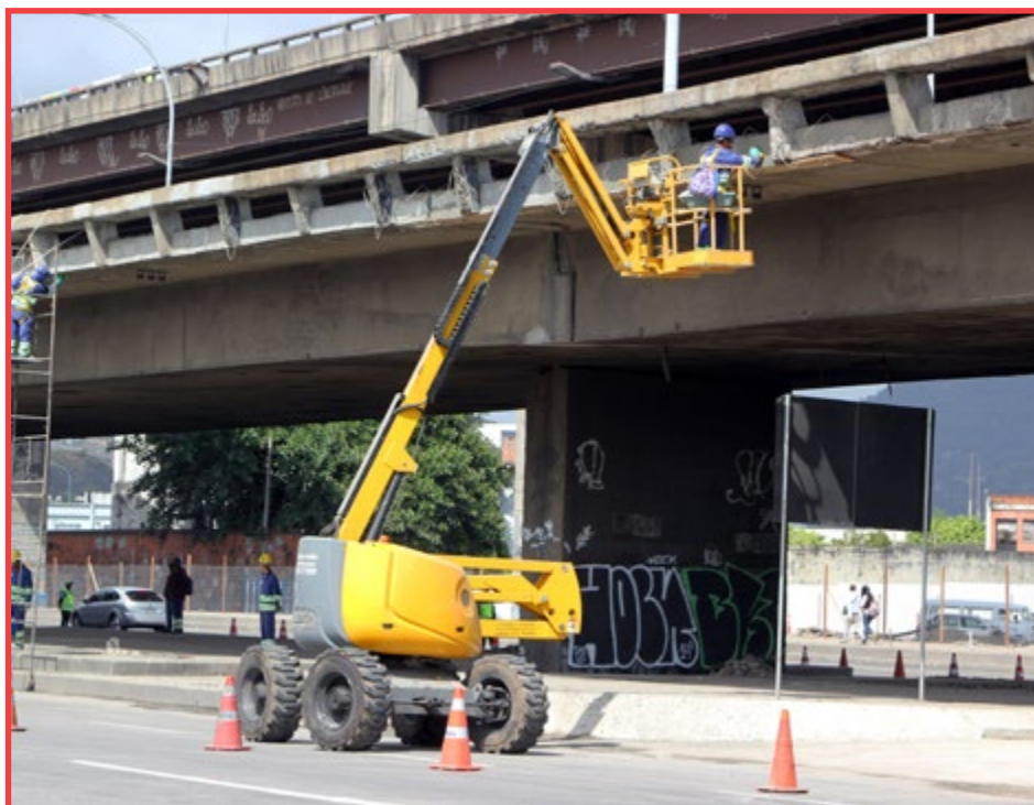
Equipe realiza reparos no Gasômetro. Ação é prevista pelo Plano de Manutenção e Recuperação de Viadutos da Região Portuária
