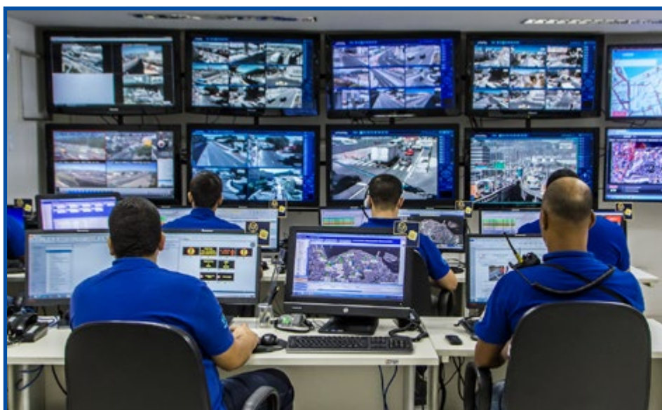
O SISTEMA IMPLANTADO NO BAIRRO DA SAÚDE É LIGADO AO CENTRO DE CONTROLE DE OPERAÇÕES DA PORTO NOVO, QUE RECEBE AS INFORMAÇÕES E PROVIDENCIA AS AÇÕES NECESSÁRIAS
